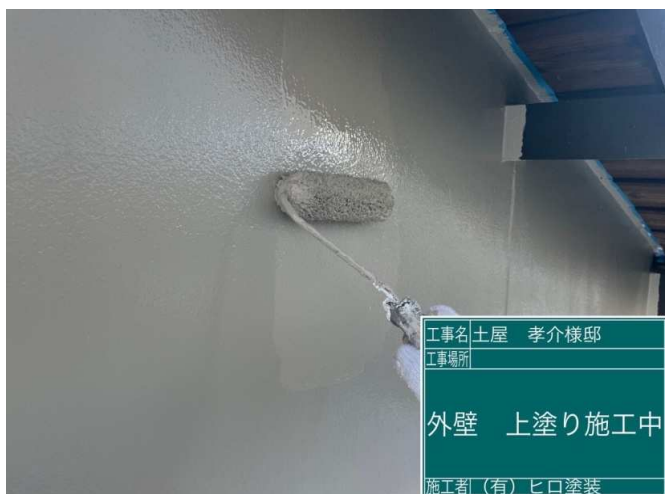
19 外壁モルタル 上塗り 施工中
