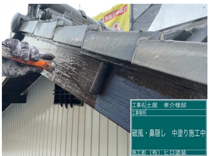
23 破風板 中塗り 施工中
