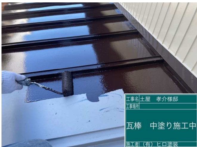
29 瓦棒屋根 中塗り 施工中
