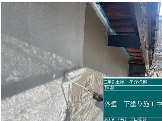
15 外壁モルタル 下塗り 施工中
