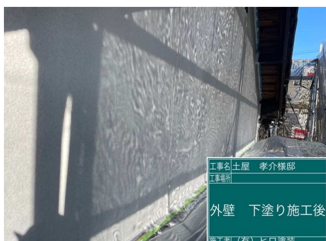
16 外壁モルタル 下塗り 施工完了
