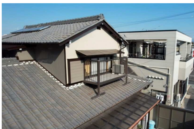
33 施工完了(ドローン撮影)
