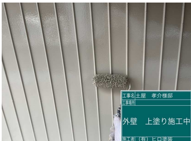
7 外壁白トタン 上塗り 施工中
