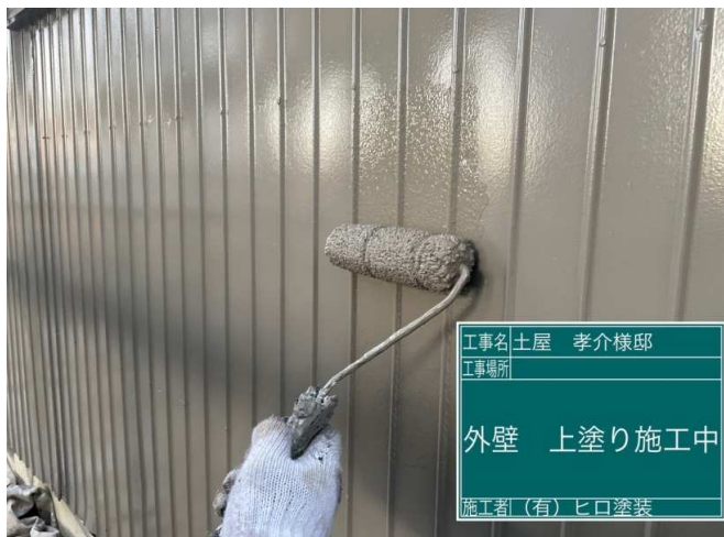
13 外壁トタン 上塗り 施工中
