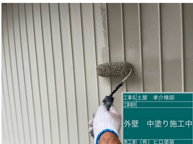
5 外壁白トタン 中塗り 施工中
