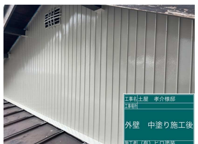
6 外壁白トタン 中塗り 施工完了
