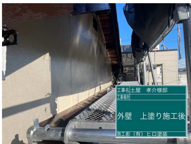
20 外壁モルタル 上塗り 施工完了
