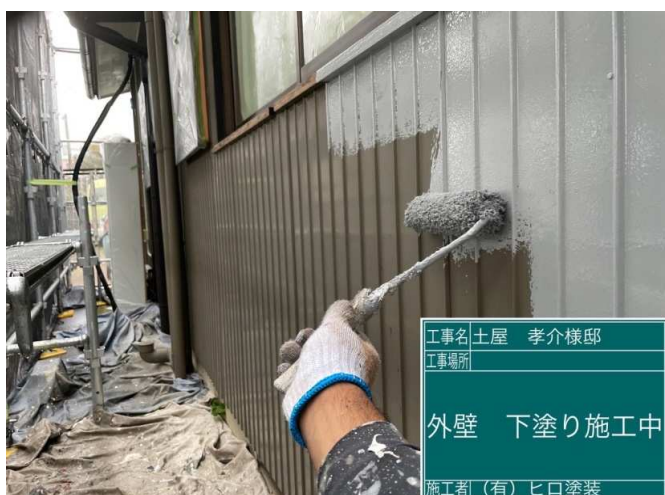
9 外壁トタン 下塗り 施工中
