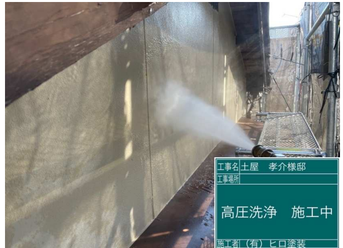
2 高圧洗浄 施工中
