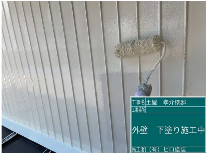
3 外壁白トタン 下塗り 施工中
