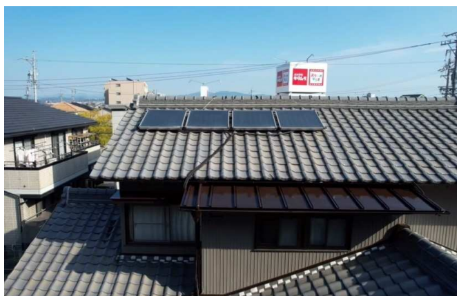
35 施工完了(ドローン撮影)
