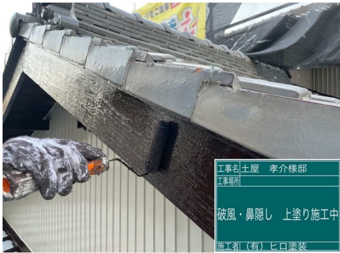
25 破風板 上塗り 施工中
