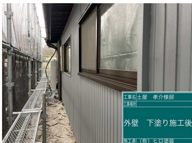
10 外壁トタン 下塗り 施工完了
