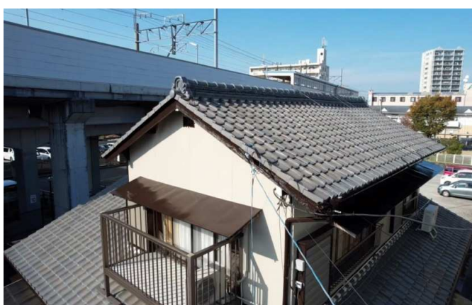
34 施工完了(ドローン撮影)
