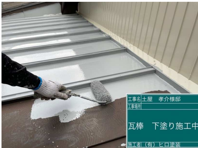
27 瓦棒屋根 下塗り 施工中
