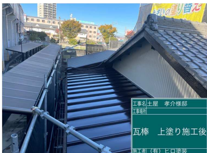
32 瓦棒屋根 上塗り 施工完了
