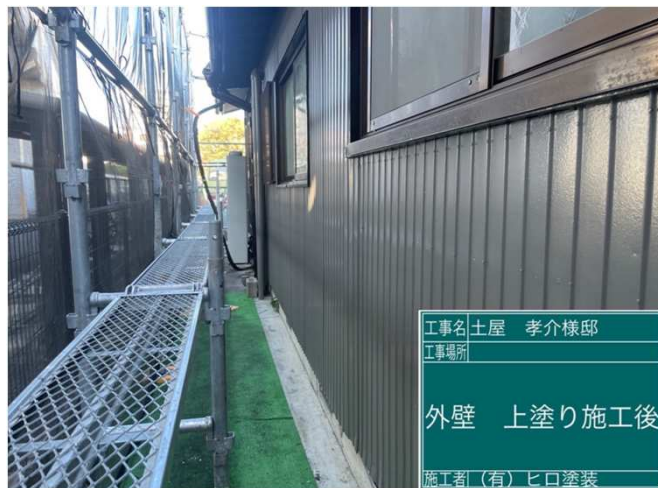
14 外壁トタン 上塗り 施工完了
