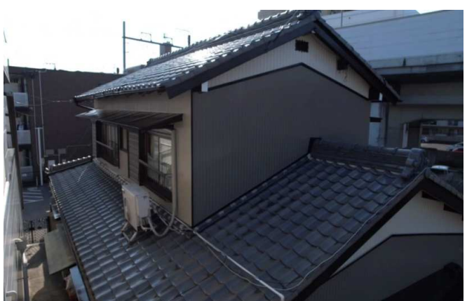
36 施工完了(ドローン撮影)
