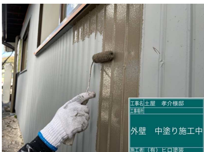
11 外壁トタン 中塗り 施工中
