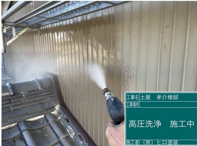
1 高圧洗浄 施工中
