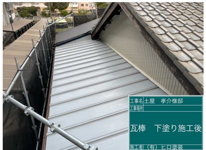
28 瓦棒屋根 下塗り 施工完了
