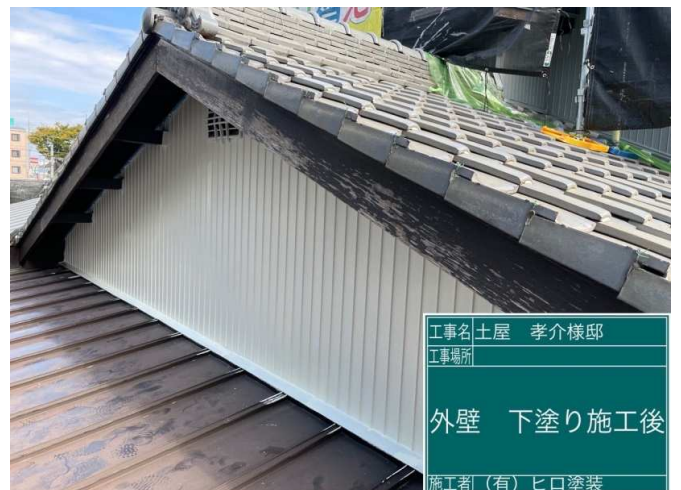
4 外壁白トタン 下塗り 施工完了
