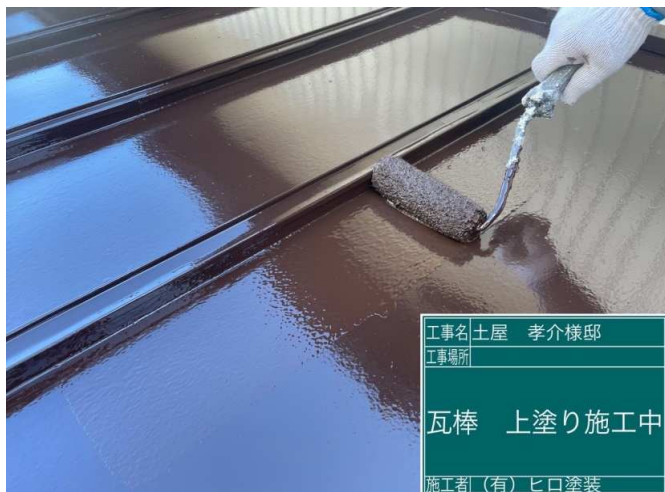
31 瓦棒屋根 上塗り 施工中
