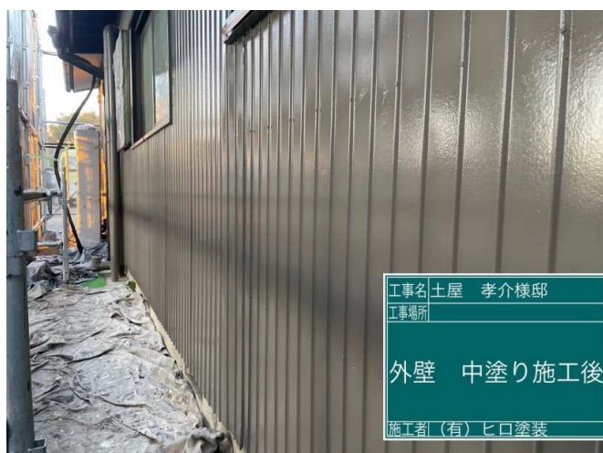
12 外壁トタン 中塗り 施工完了
